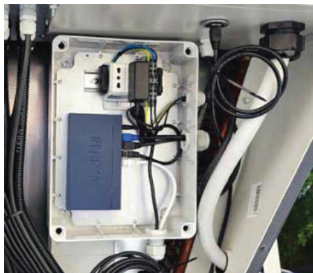
Tekening 16: Cascade aansluitmodule met ethernet bekabeling
